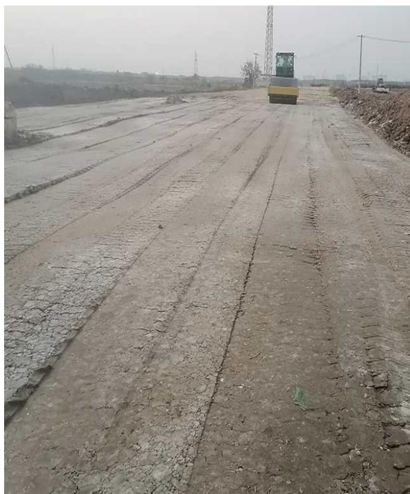
临时道路施工
